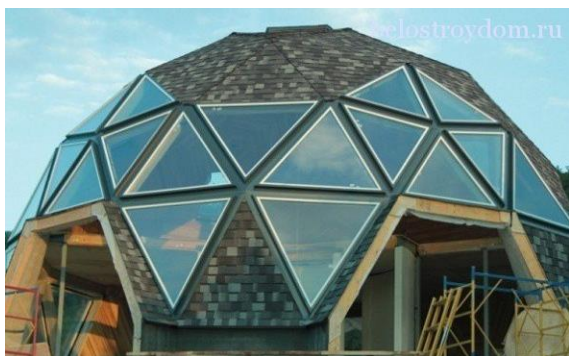
Рис. 4. Пример размещения окон при строительстве купольного здания
