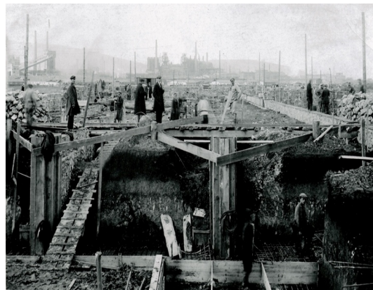
Рис. 1. Закладка фундамента будущего здания старого корпуса СМИ (фото 1932 г.)
