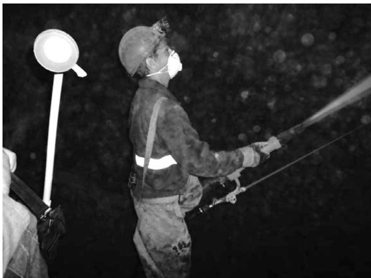
Рис. 3. Работа сопловщика стволом *TERMITON X4*
