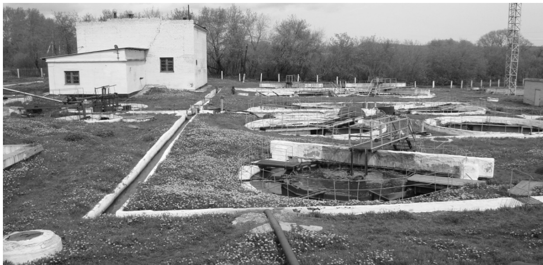
Рис. 1. Очистные сооружения 5-го канализационного бассейна
