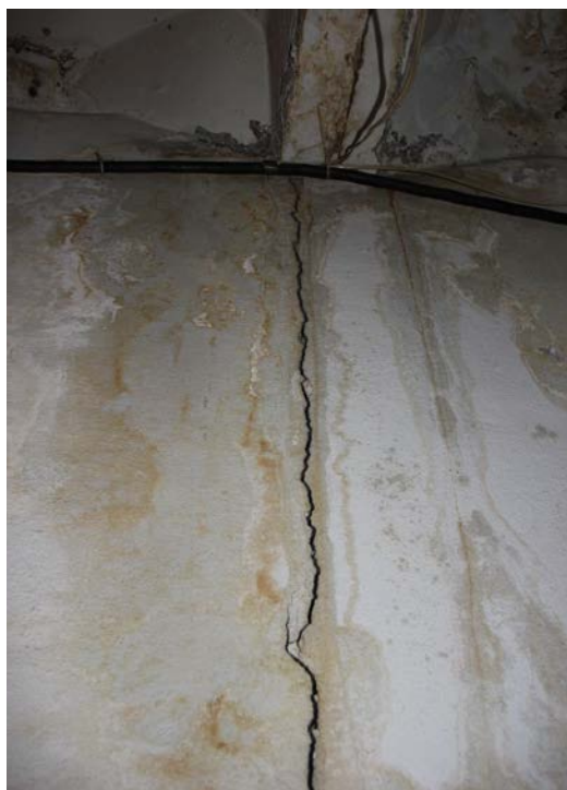
Рис. 4. Вертикальная трещина в поперечной стене по оси 4 на третьем этаже между осями Б и В . Ширина раскрытия 6 – 8 мм, начало от потолка
