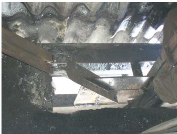
Рис. 1. Разрыв раскоса фермы пролетного строения
