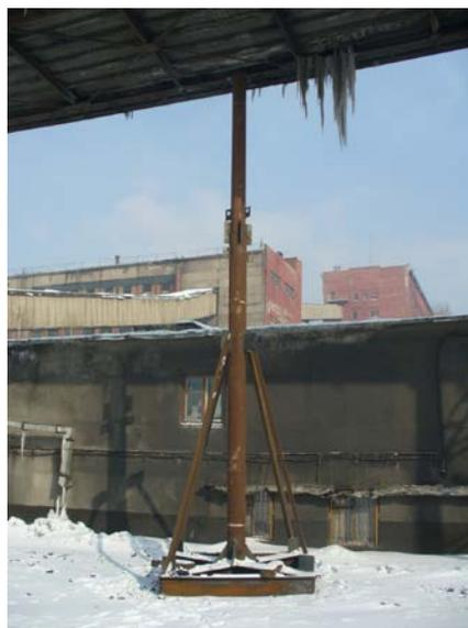
Рис. 2. Временная дополнительная стойка
