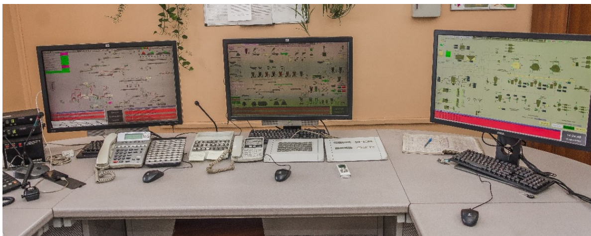
Рис. 2. АРМ диспетчера на базе SCADA-системы Genesis32
