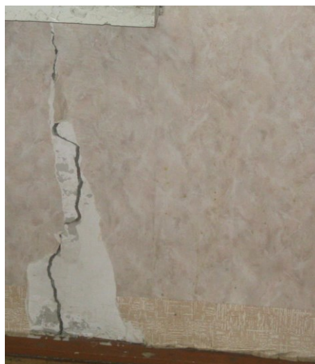
Рис. 3. Трещины в месте невыполненного деформационного шва с наружной (а) и с внутренней (б) стороны стены
