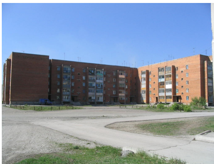
Рис. 1. Общий вид жилого дома
