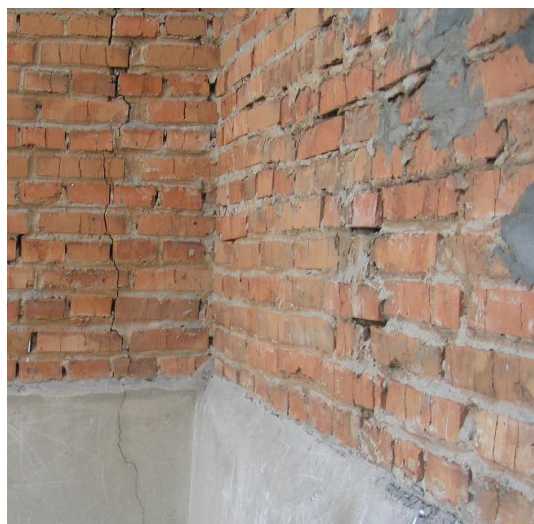
Рис. 3. Трещины в месте невыполненного деформационного шва с наружной (а) и с внутренней (б) стороны стены
